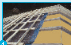
4 Pose des contre-liteaux et des liteaux.
