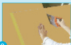
2 Les coupes peuvent être réalisées sur le toit à l'aide d'une scie égoïne.
