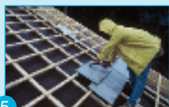
5 Pose de la couverture.
