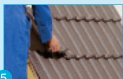
5 Pose de la couverture.
